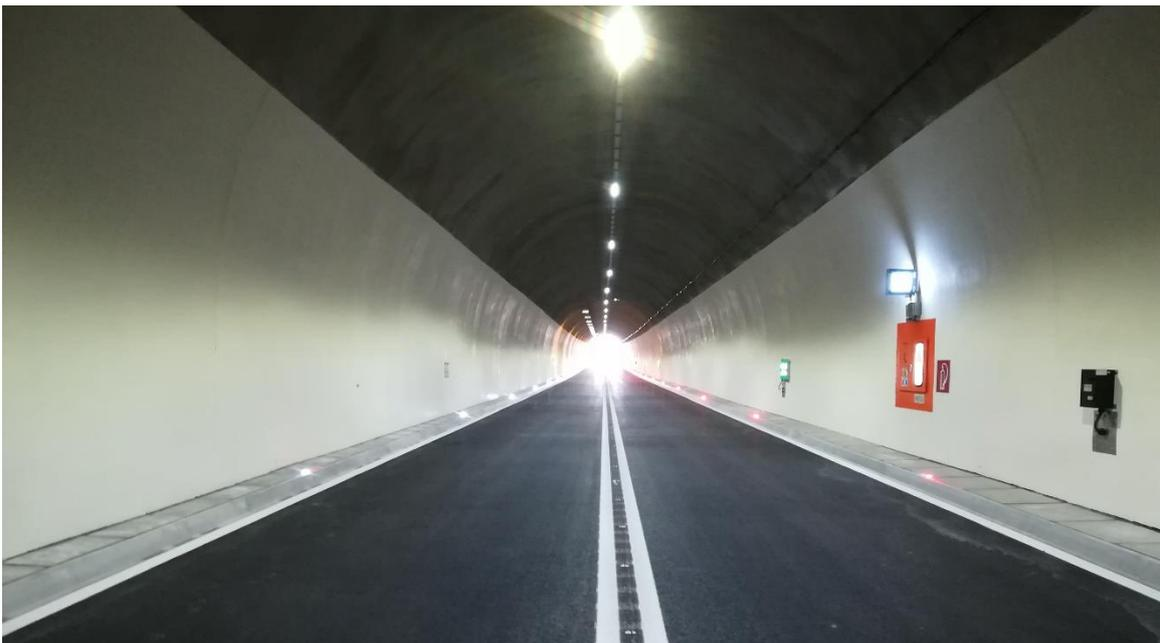
Abbildung 3: Weißzementmörtel bis 4,50 m auf Innenschale aus Spritzbeton.
